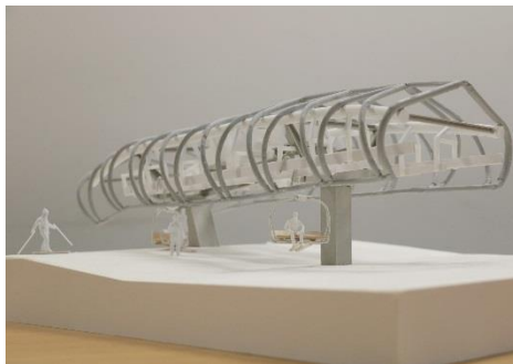
基本計画時の上屋骨組み(製品版では変更あり)
